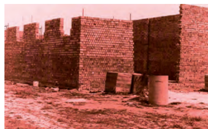
▲ Ermita en plena construcción
